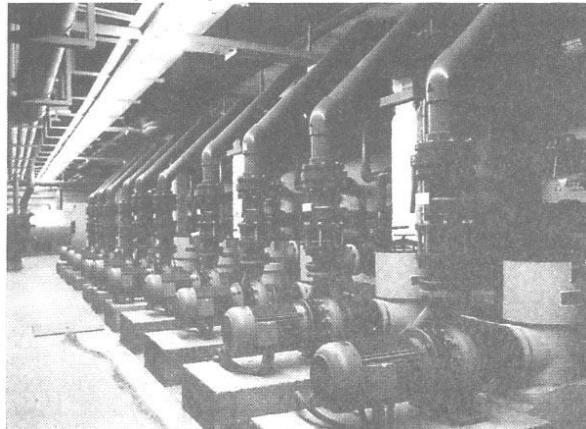
Производительность насосов должна выбираться такой, чтобы обеспечивался нужный поток и нужный напор воды. Обычно достаточным является напор воды, равный 10 м водяного столба, но это значение может меняться в зависимости от конкретной установки.
